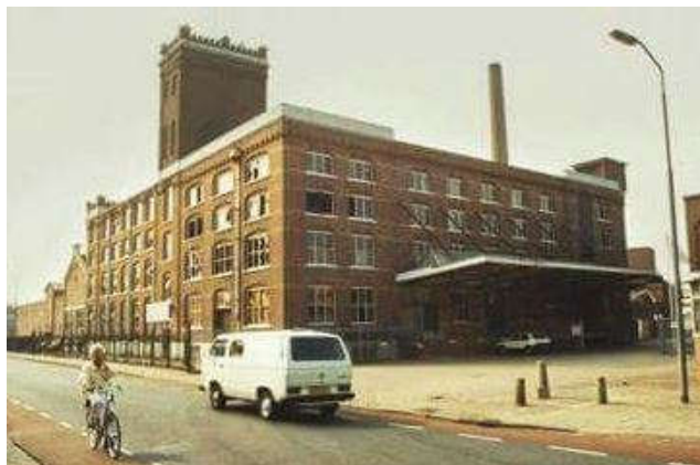
Voormalige jutefabriek Ter Horst - Rijssen
